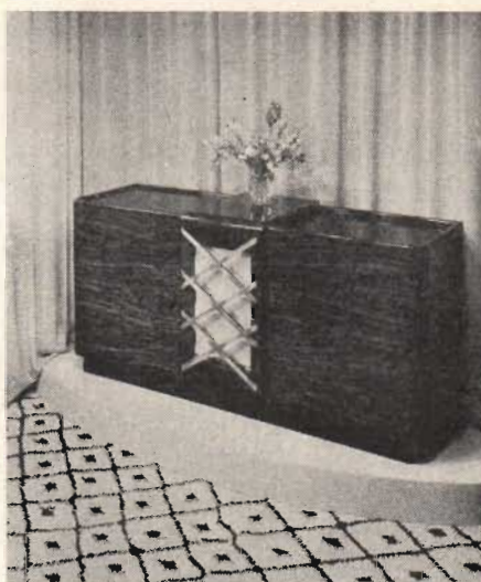
Fig. 1. En av utställningens största radiomöbler. Denna apparat är en 9-rörs super med högtalare med 32 cm diameter. Skivväxlare ingår i apparaten.
