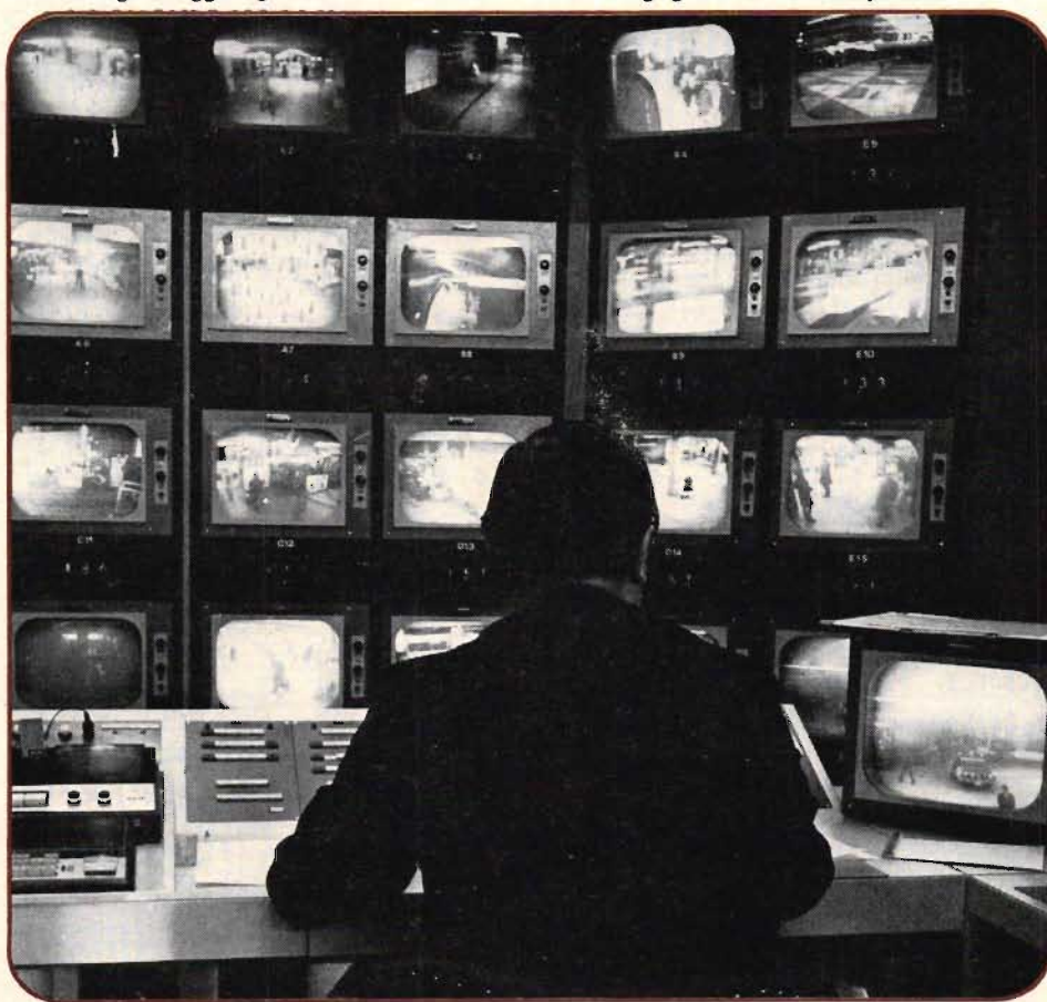
Fig. 1. I monitorstativet i tunnelcentralen visas bilder från — för närvarande — sju T-banestationer. De tre största stationerna kan kräva extra uppmärksamhet och intensivbevakning sätts då in. T-centralen, t ex, kan observeras med tio samtidiga bilder genom att fyra monitorer "lånas" från Hötorget.
