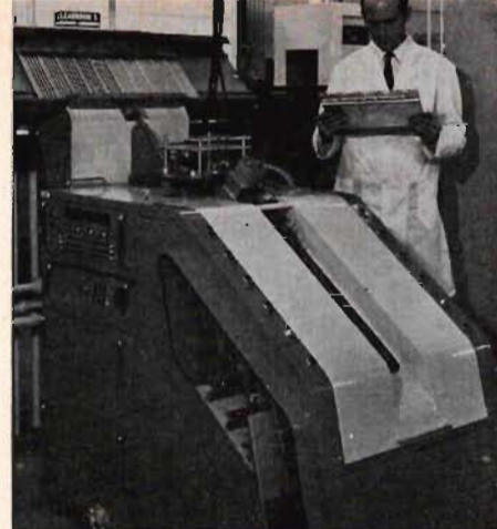
Fig 3. Automatisk provnings-, sorterings- och förpackningsmaskin. 64 parametrar kan mätas med hastigheten två per sek.
