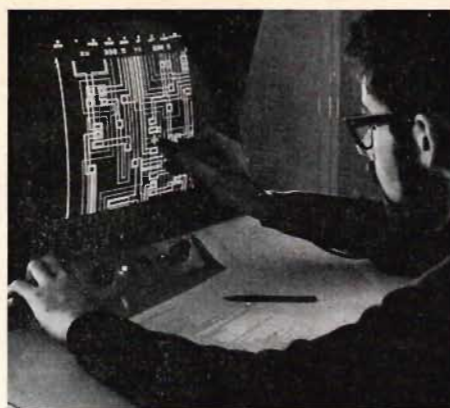
Fig 2. Design av en kretslayout med hjälp av ljuspenna plus grafisk display.
