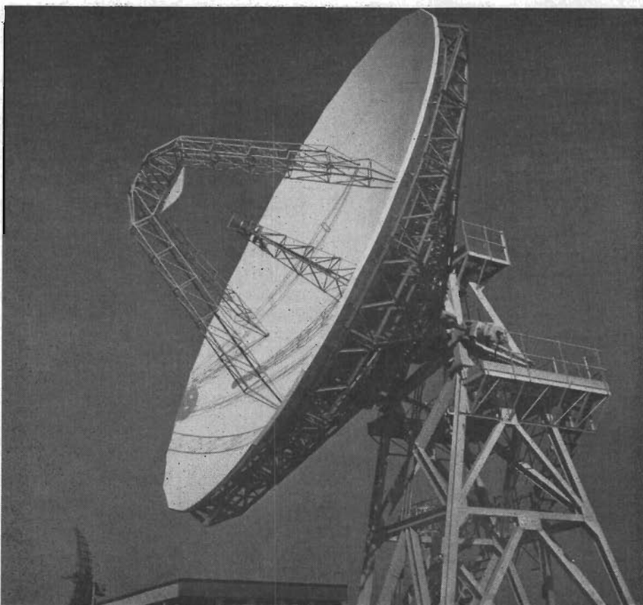
Fig. 5. En 14 m parabolantenn tillhörig en experimentsatellitstation med terminal vid Cowes på Isle of Wight och konstruerad av Plessey Radar.
