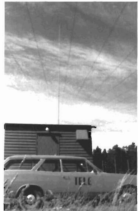
Fig 9. Vertikalantenn för registrering av radiobruset vid ARN i Enköping. Obs jordplanswirarna.
