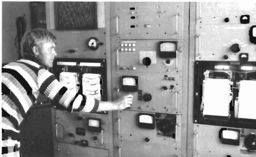
Fig 8. Interiör från Enköpings station för registrering av radiobruset. Skrivarna till vänster registrerar underlag för analys av olika bruskomponenter i radiobruspektrat. Skrivarna till höger ger medelbrusnivån under varje märkepass. Kalibreringsutrustning och automatik i mitten.
