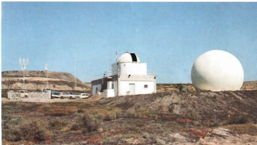
Fig 2. Ett solobservatorium är anslutet till kontrollstationen. I den stora globen döljs radioteleskopet.
