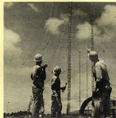
Sändarantennerna kräver en ständig översyn p g a den höga, saltbemängda luftfuktigheten.
