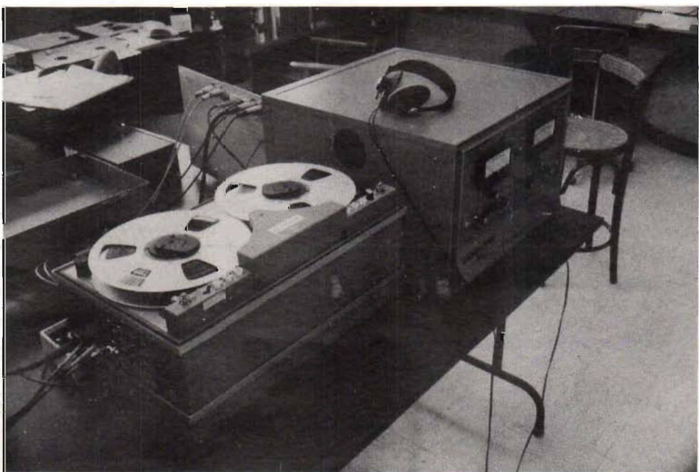
Fig 8. Så här ser den digitala bandspelaren ut. Bandmaskinen är av fabrikatet Honeywell och arbetar med 76 cm/sekund bandhastighet. Den huvudsakliga elektroniken är placerad i apparatlådan till höger på bilden.
