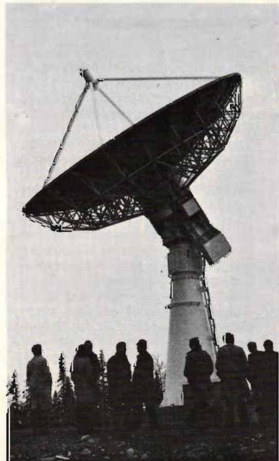
Fig 1. Den 9,14 m stora parabolantennen tar emot Landsatinformation vid Esrange.
