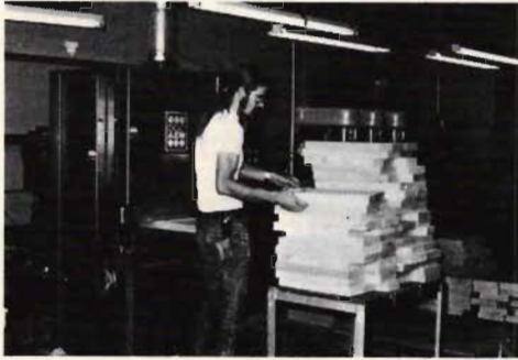
Maskinslipning av amnen till massiva gitarrkroppar.
