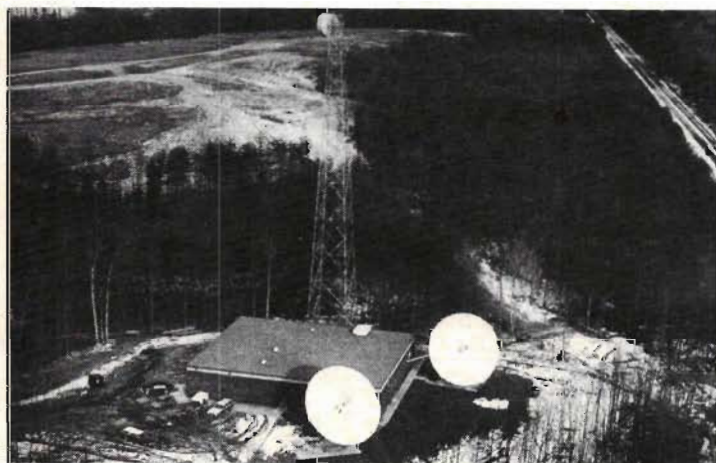
Fagely av PBS Main Origination Terminal, centrum i natets nya satellitdistribuerade programsystem. Program som sänds ut från PBS-studiorna i Washington överförs hit via mikrovågslänk på det höga antenntornet bakom bilden. Parabolerna i förgrunden är antennerna för sändning resp mottagning över Western Unions Westar 1 kommunikationssatellit. Signalerna transmitterade från Westar mottages över de sk allmänna tv-stationerna över hela USA jämte Puerto Rico samt Jungfruöarna.
