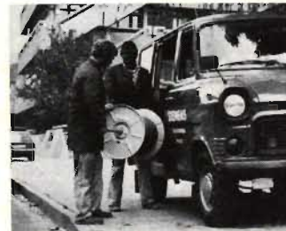
Fig 2. En utmärkt egenskap hos optisk kabel är den mycket låga vikten. 1000 m kabel på trumma väger ca 50 kg och läggs ut i en längd.
