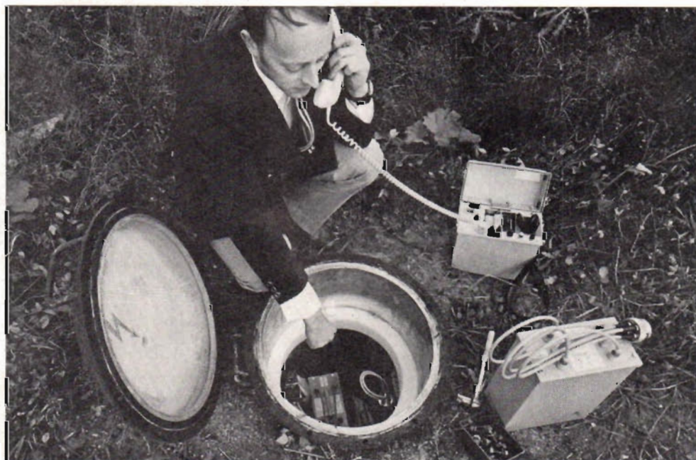
Fig 2. Förstärkarna är placerade i järnbehållare som grävs ned i jorden i direkt anslutning till kabeln.
