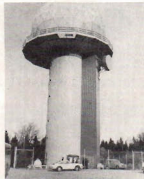
Fig 2. Radarantennen är skyddad innanför radomen av glasfiberarmerad plast.
