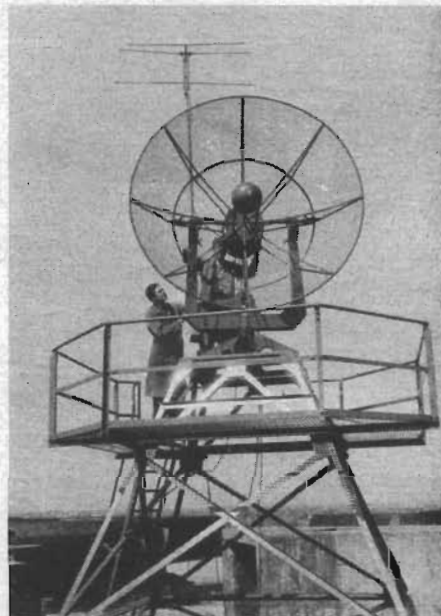
Riktantenn på taket på TV-studion i Hamburg avsedd för reportagevagnarna.
