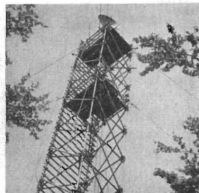
Antenntorn tillfälligt uppbyggt i Alembon för riktantennerna för radiolänken London—Lille.
