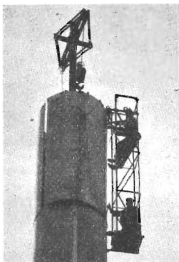
Fig. 3. Antennmasterna byggs upp på så vis, att plåtarna hissas upp med ett spel, som drivs av en motor, som placerats inne i masten. Två man skruvar fast bultarna, som håller ihop antennelementen.
