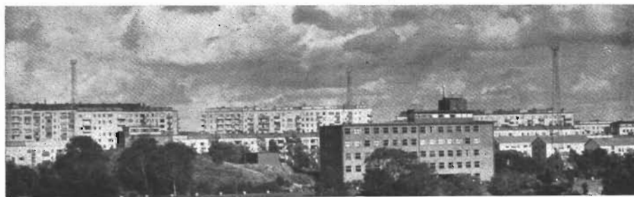
Fig. 2. Göteborgs TV-sändare kommer att provisoriskt sättas upp på Chalmers Tekniska Högskola. Bilden visar den byggnad tillhörande högskolans institution för elektronik, där TV-sändaren kommer att installeras (den lilla byggnaden t.v. på kullen) och de antenntorn som kommer att utnyttjas för sändarens antensystem.
