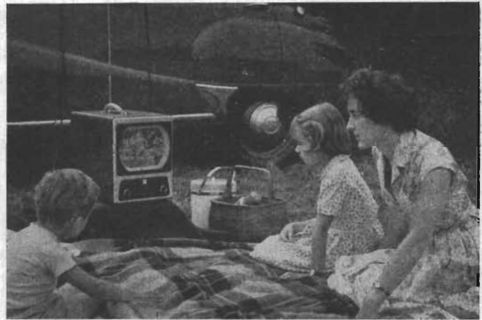
Fig. 13. Första europeiska rese-TV-mottagaren. Går på 6 V ackumulator, alternativt på nät. Försedd med 9" bildrör och kanalomkopplare. Kan också användas för FM-UKV-mottagning. Vikt: ca 15 kg. Tillverkare: E K Cole Ltd.
