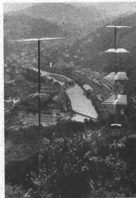
Fig. 1. T.h. »reläantenn» riktad mot samhället Altana, som skymtar längst bort i dalgången. T.v. antennen för det radiomanövrerade inkopplingsreläet. Se fig. 3.
