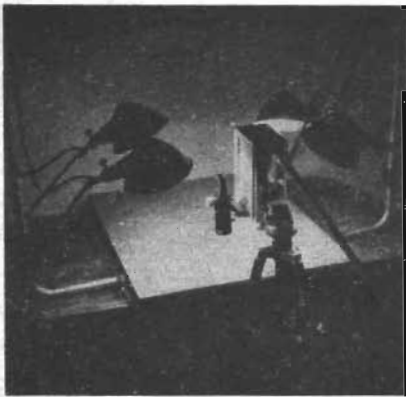
Fig. 6. TV-utrustning i kriminalpolisens tjänst. De föremål som skall undersökas lägges på det starkt belysta underlaget. TV-apparatur: Grundig Radiowerke.
