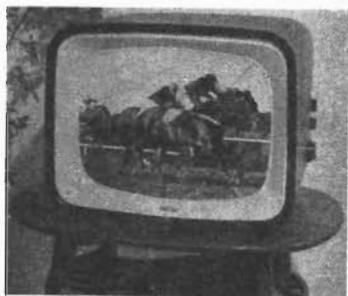
AGA:s sensationella TV-mottagare med tryckt ledningsdragning. Ytermått: 46×38×40 cm.
