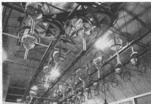
Fig. 2. Ett omfattande system av löpande band i taket transporterar bildrören mellan de olika avdelningarna vid E.M.I. Factories Ltd., en av Englands största tillverkare av bildrör.
