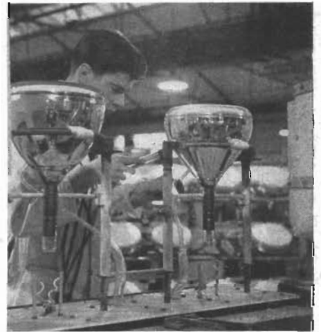
Fig. 7. Nästa etapp är att röret anbringas i automatiska pumphaskiner som utför den definitiva evakueringen och »avgasningen». Man använder därvid 28 »truckar», varje truck är utrustad för att betjäna två bildrör. Truckarna drives fram i en ellipsformad bana. Bilden visar hur ett rör anslutes till evakueringspumpen i en evakueringstruck. Evakueringen sker kontinuerligt under det att truckarna transporterar bildrören runt spåret för olika kontrollåtgärder m.m.
