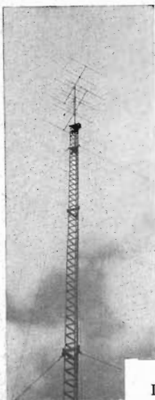
Mottagareantennen, en 2-vånings Yagi-antenn, är monterad i toppen av en 30 m hög antennmast, där också en antennförstärkare är anbringad.
