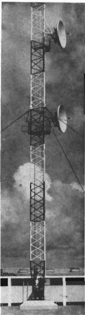
Fig. 1. Ståltorn av detta slag kommer att användas i den provisoriska TV-linjen Stockholm—Göteborg—Malmö.
