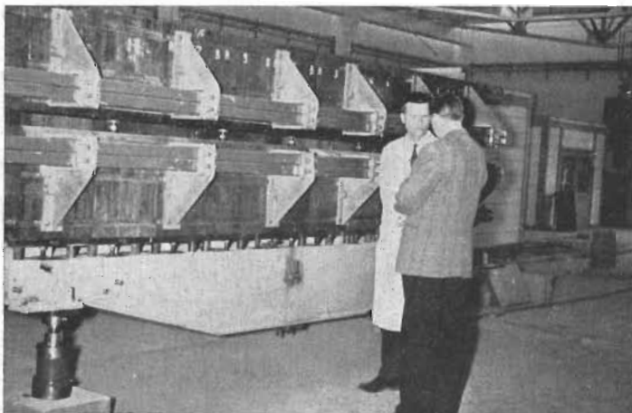
Civilingenjörerna Jörgen Nilsson och Bengt Hedin — den sistnämnda tidigare teknisk chef vid The Svedbergs cyklotronlaboratorium i Uppsala — framför ett av synkrotronens 100 magnetblock. Varje magnet är 4,75 m lång och har en mycket komplicerad konstruktion.
