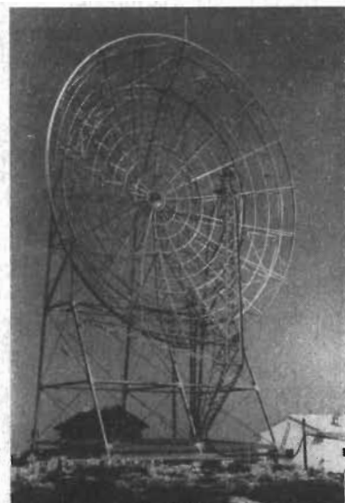
Fig. 1. Detta är de jättestora antenspeglar som användes för TV-länkförbindelsen mellan Florida och Cuba. I bakgrunden den andra antennen i överföringssystemet, som är dubblerat helt igenom.
