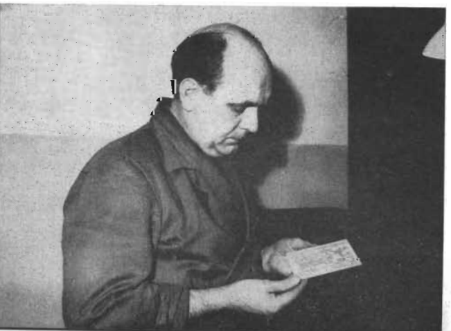
Nedan: Silk-screen-metoden går bra att tillämpa även när det gäller tryckta spolar. Här granskas en TK-platta med tryckta spolar, avsedd att ingå i MF-delen i en TV-mottagare.
