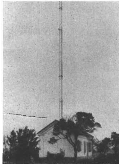
5 km nordöst om Trelleborg står radiostationen för radiotelefonförbindelsen Trelleborg—Sassnitz. Masten är 100 m hög och har i toppen riktantenner för 160 resp. 80 MHz. På halva topphöjden återfinnes antenner för radioförbindelsen med Malmö.
