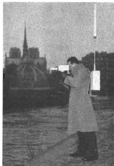
Ovan: Detta är en av den franska televisionens portabla TV-reportageutrustningar. Hela apparaturen, som är nästan helt transistorbestyckad, inkluderar kamera, synkgenerator, sändare och antenn, och kan bäras av en man. Kameraröret är av vidikon-typ. Frekvensen som användes vid överföringen är 200, 500 eller 7000 MHz. Foto: C.S.F., René Bouillot.
