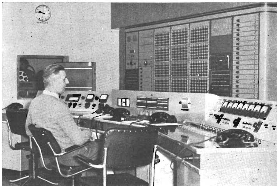
I huvudkontrollrummet i München övervakas sändningarna från studiorna i München till RFE:s 28 sändare i Västtyskland och Portugal, vilka därefter återutsänder dem i riktning mot fem länder bakom järnridån.
