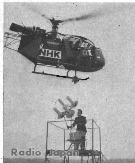
Fig 2 Helikopter (överst) med TV-kamera, sändare och antenn användes av NHK i Japan. Med en spiralantenn (nedan) uppfångas TV-signalerna från helikoptern och reläas till studion.
