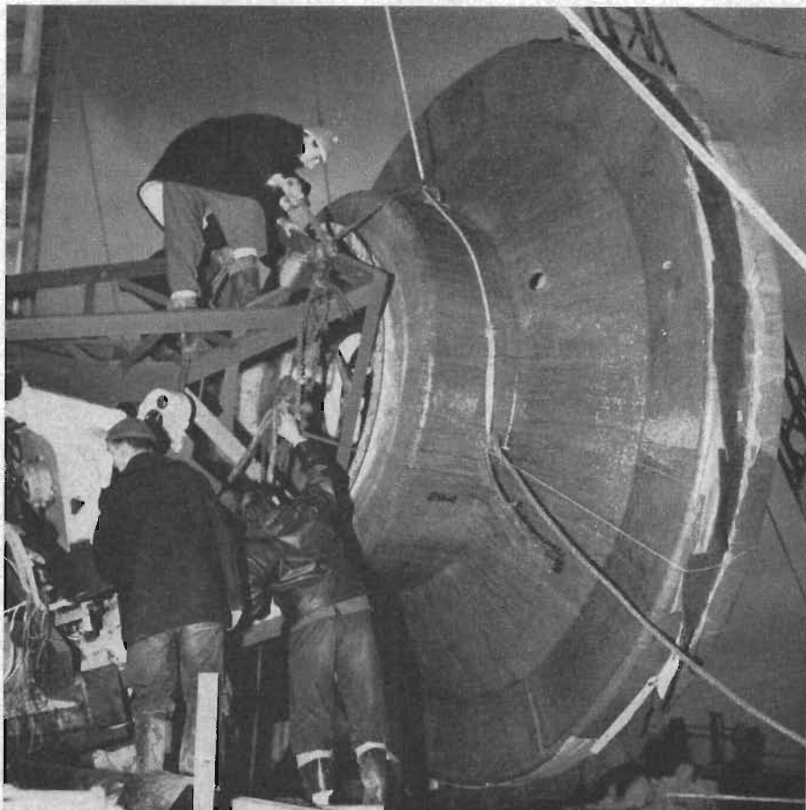
Radioteleskopet vid Coxite Green har en parabolantenn med 4,5 m diameter.
