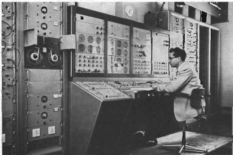
Fig. 5 Mottagarutrustningen för det nya radioteleskopet vid Mullard-observatoriet är placerad i observatoriets laboratorium. I mitten finns bl. a. den utrustning som indikerar de tre antennernas inriktning. T. v. om man över pulpstenen ses den hålremsläsare som »läser in» programremsan för styrning av teleskopet.
