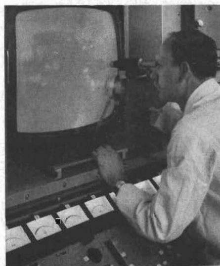
Fig 6. Färgkameran KC 4P40 från Fernseh GmbH med tillhörande monitorstativ. Denna kamera arbetar med fyra Plumbiconrör!
