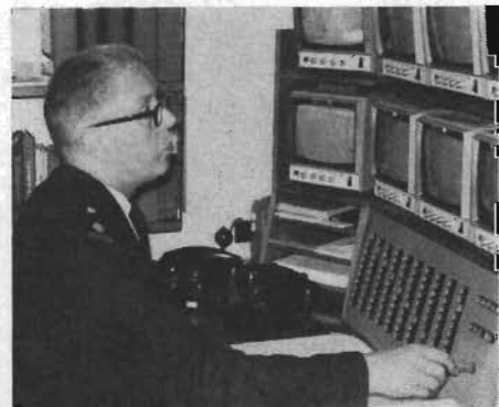
Fig 2. Stockholms Central TV-övervakas av polisen. Anläggningen har levererats av Securitas.
