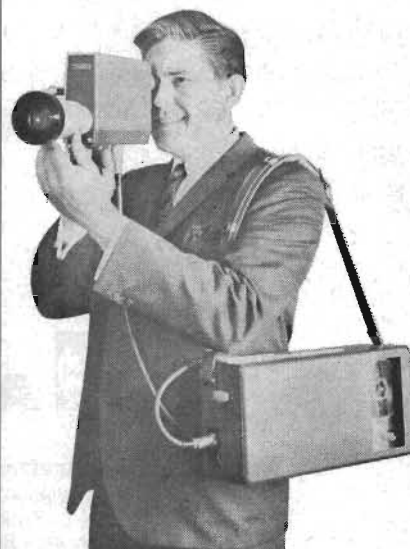
Shibaden SV-707E, portabel videoinspelningsmaskin och kamera. Mikrofonen skymtar bakom objektivet.
