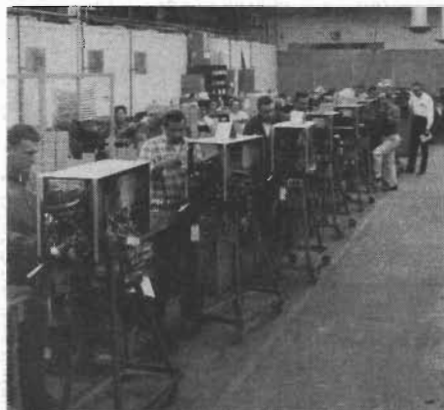
Fig 3. Löpande band-montage av kamerorna hos GE med specialskolat folk vid varje station.
