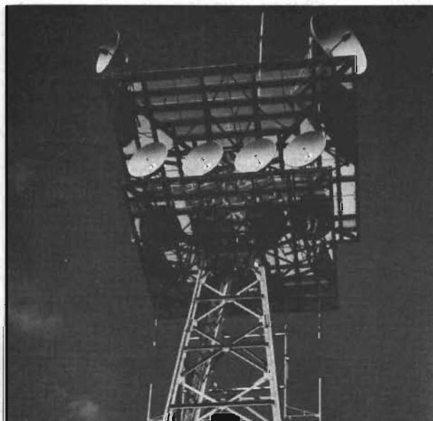
Fig 1. Experimenten i Västtyskland med 12 GHz-överförd TV fortsätter. Här ses en stations antensystem, »Richtfunkstelle Hoher Westerwald».
