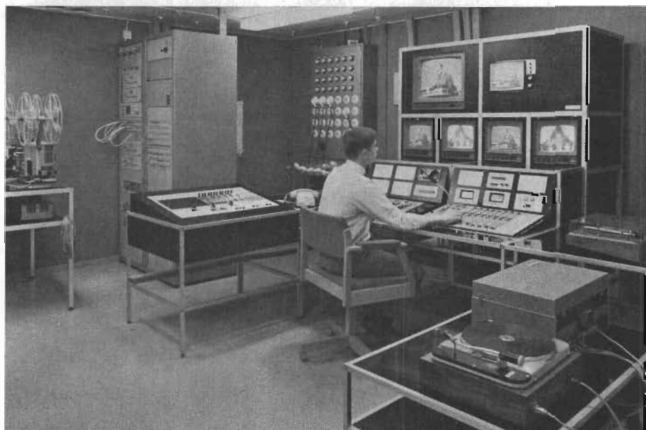
Fig 3. Kontrollrummet. — De två staffven i fonden innehåller bl a fyra CCU (kamera-kontrollenbeter) med fjärrstyrning från mixerpulten, HF-modulatorer, bild- och ljudtrunkpaneler, filterkryss och förstärkare för videoreglerna. En femte CCU, för Plumbicon-färgkamera ingår också. Den används tills vidare för tre S/V-kameror gemensamt.
