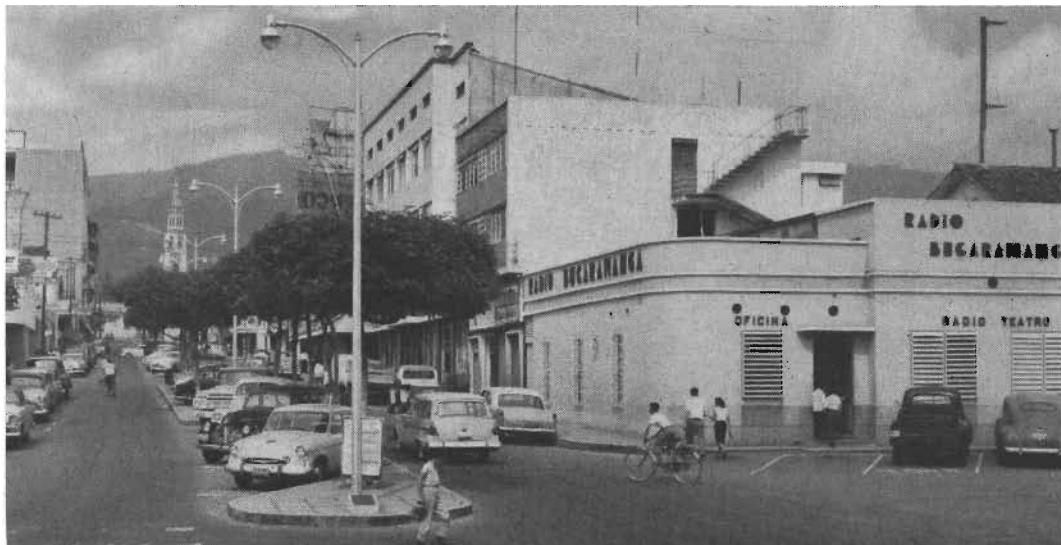
Radio Bucaramangas moderna radiohus med bl a sändarantennerna monterade direkt på taket.
