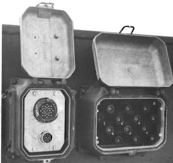
Bild 8. Telefonapparater kan anslutas till polskruvstavor, som sitter inne i baskabelskåpen eller i dosor på skåpens ut-sida
