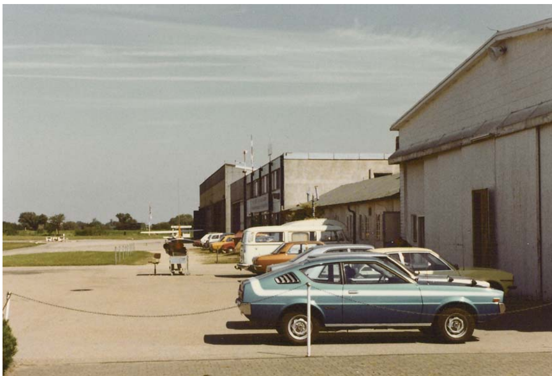
Hangaren med flygradioverkstad vid Baden-Oos.
