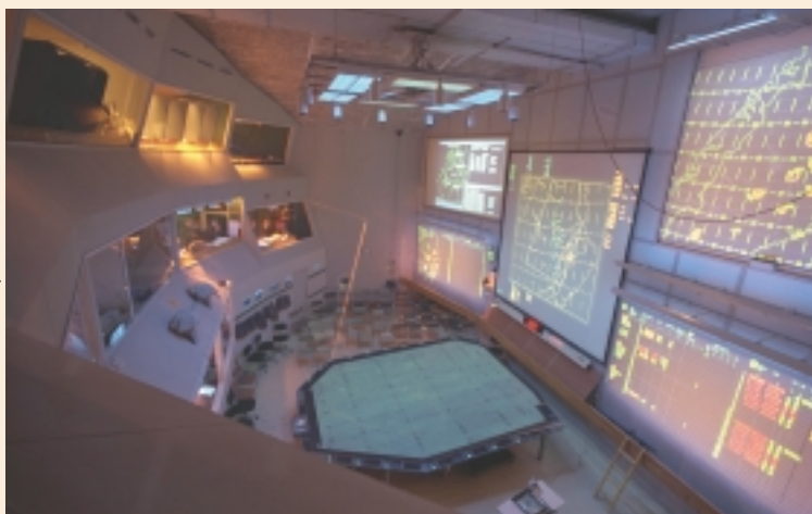
Stridsledningscentral i STRIL 60. I operativt bruk 1977-1998
