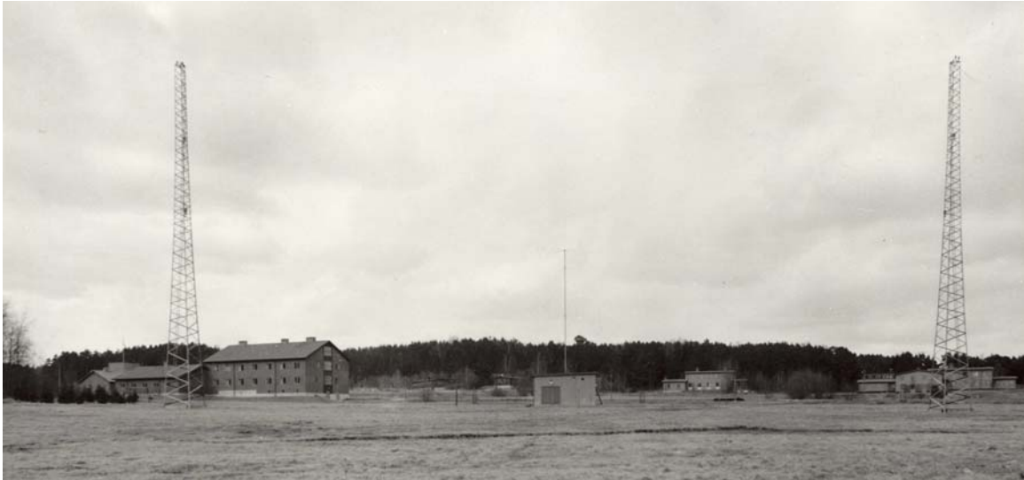
F2 sändarstation med Fackverksmasterna för LV-antennen. Foto Flygvapenmuseum.
