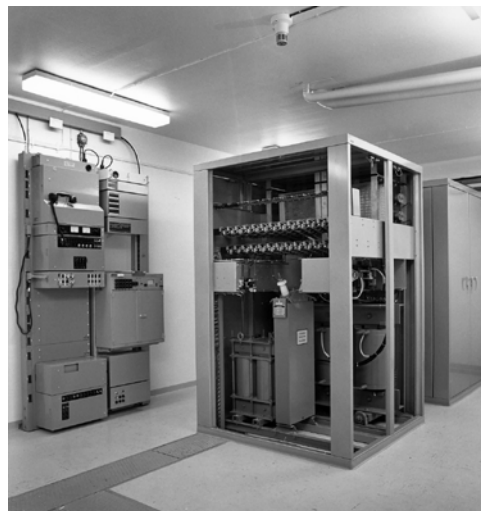
Radiolänkutrustning strömförsörjningsenhet
