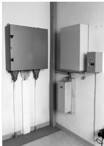
Kopplingskåp Snabbtelefonutrustning
