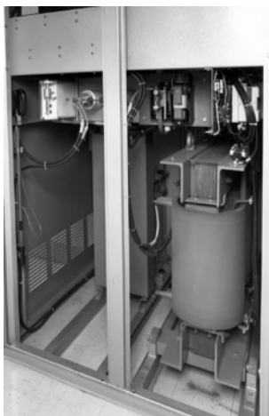
Strömförsörjningsenhet
