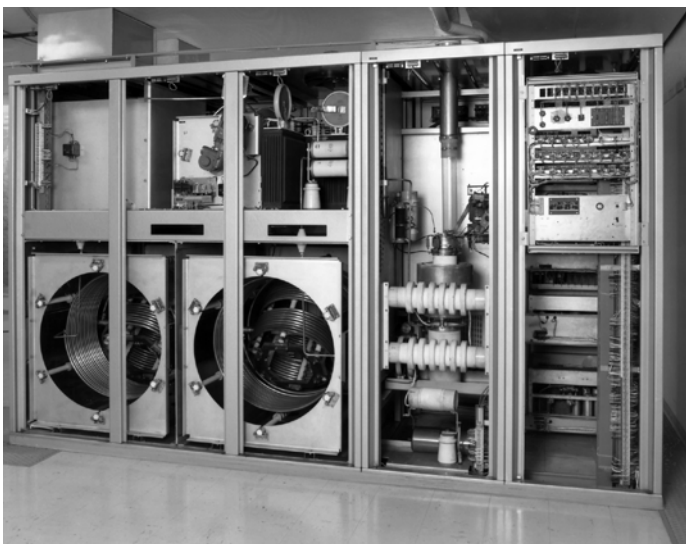
Slutsteg med rör anodkretsvariometer
