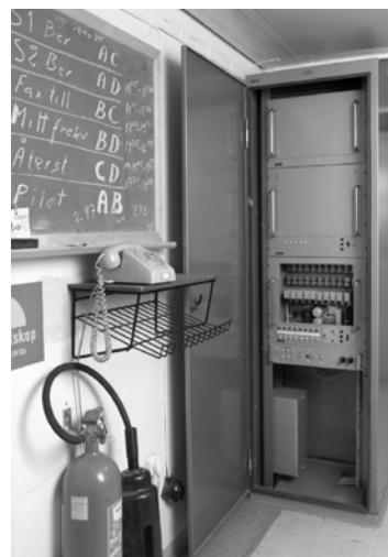
Sändarbyggnad fjärrmanöverutrustning
