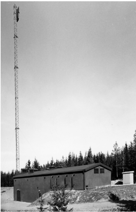
Sändarbyggnad med länkmast
