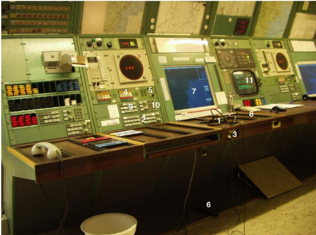
Bild 1. Centrala delar av flygtrafikledarens operatörsplats i TMC. Interfons manöverenhet (MAO) (2), är placerad till vänster om bildskärm RDP (7) -radardata. Headsetet (1). (Se ref. 12)
