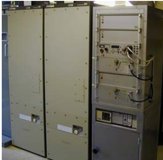
Effektsteg 204 med radiostation
