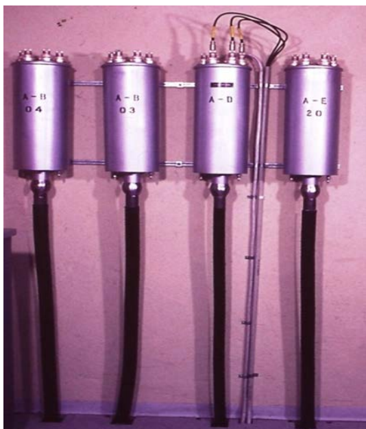
Kabelboxar och strömförsörjningsutrustning
