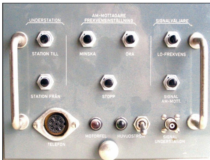
Manöverenhet för styrning av understation
