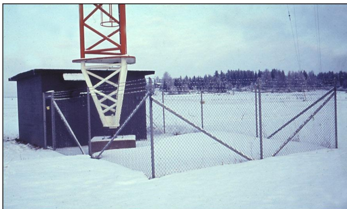
Antennmastfoten med bunkern för antennavställningsstativet
