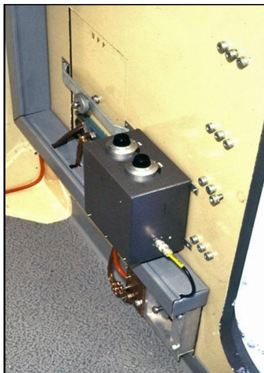
Interiör understation: Baksida med motorelverk samt framsida med elektronik.
