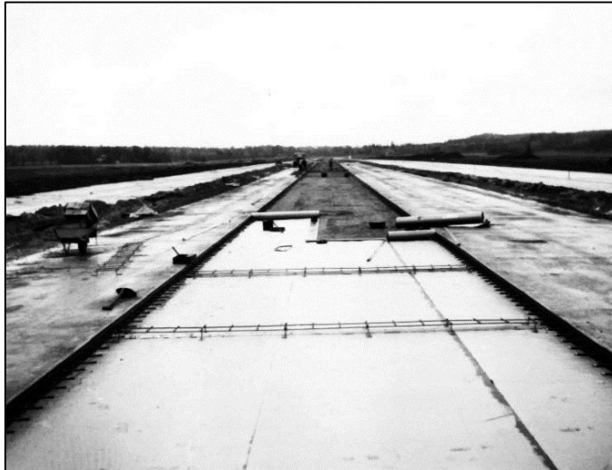
Betongbeläggning av bana 15/33 sommaren 1957
