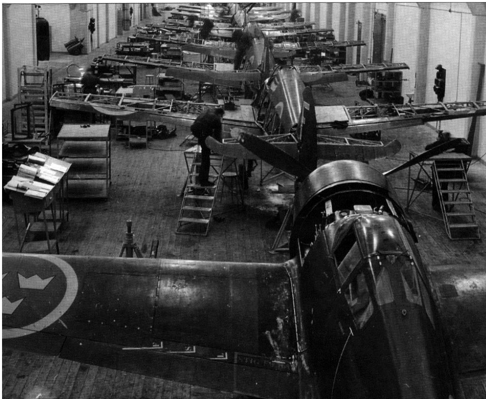
Montering av flygplan J 22 vid CVA tunnel 13 1947.
