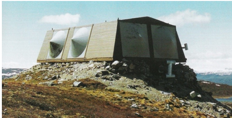
Typisk radiolänkstation i bunker från 1960-talet
