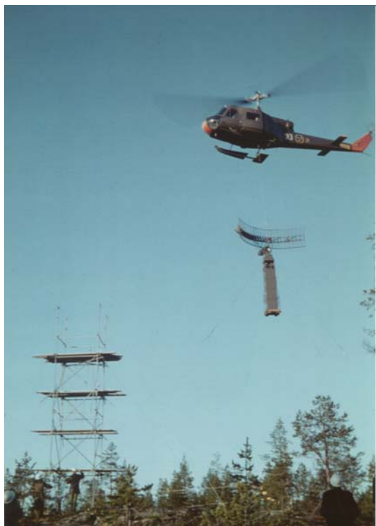
Bild 21. Jävrestationen lyfts på plats
