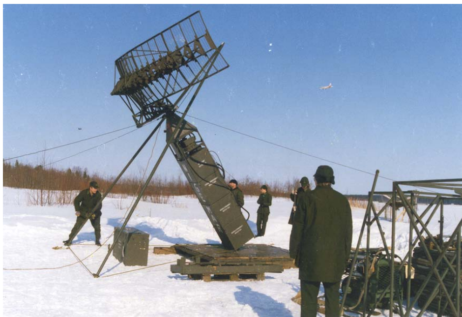
Bild 23. Stationen reses med hjälp av en speciell stolpresare, s.k. "Sparreholmssax".
