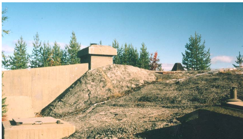
Bild 20. Exteriör av bergsskyddsrum intill Byske i Västerbotten. Antennvridenhetens placering var där den svarta konen syns (något t.h. om bildens mitt). Antennen roterade således strax ovanför marken.
