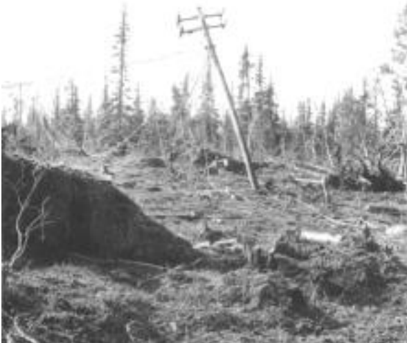
Figur 48: Bild efter provsprängning av tidstypiskt telenät. (Foto:CVA/FMV)
