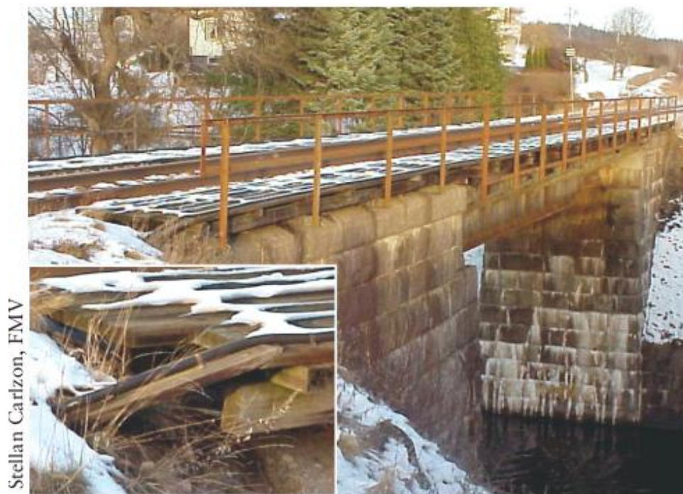
Figur 2: I publika nät är ekonomin starkt styrande. Exempel på svagt skyddad förläggning av optokabel. (Foto: Stellan Carlzon, FMV)
