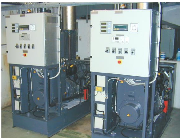
Figur 12: Strömförsörjningsutrustning (Foto: Conny Runeke, F17)
