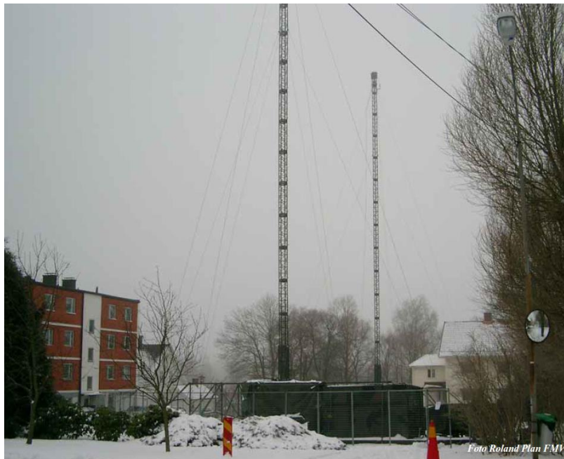
Figur 3: Transportabel radiolänk inkl. mast vid civil telestation i Älmhult efter stormen Gudrun (Foto: Roland Plan, FMV)
