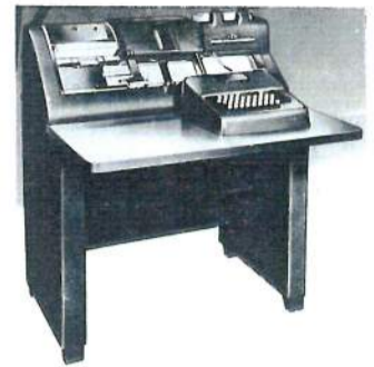
IBM 016/019 STANSMASKIN 016 som stans 019 som kontrollstans
