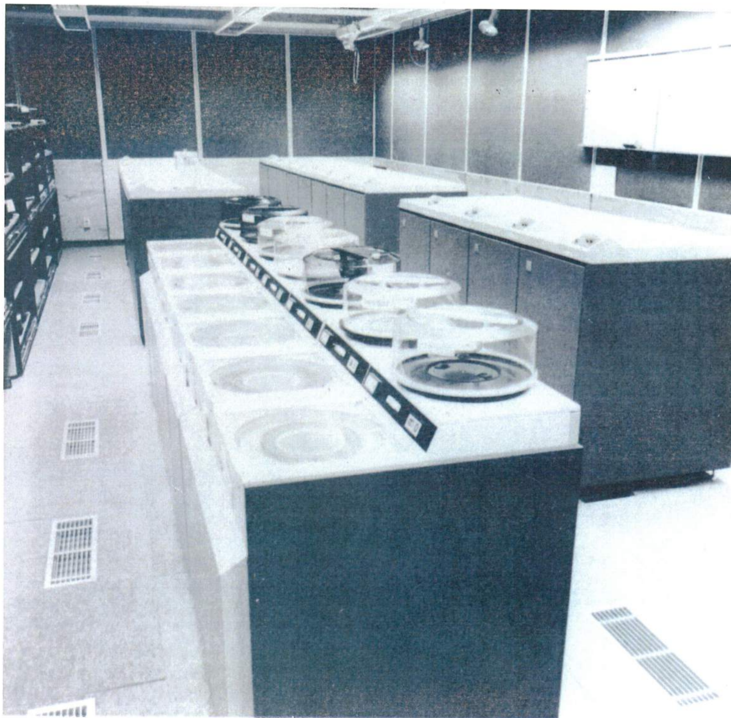
EN TYPISK DATACENTRAL
