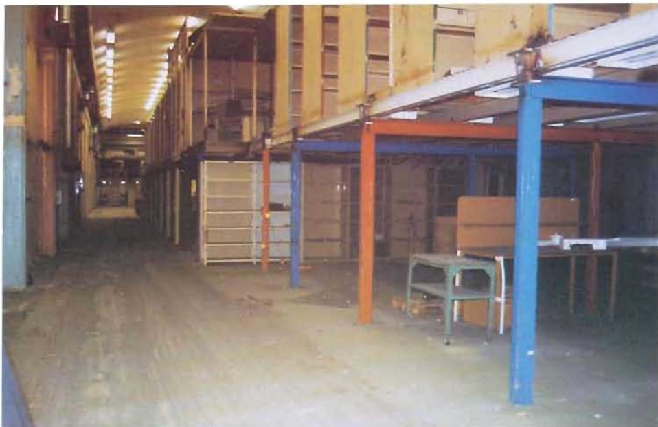
Början av rivningen i berget.
